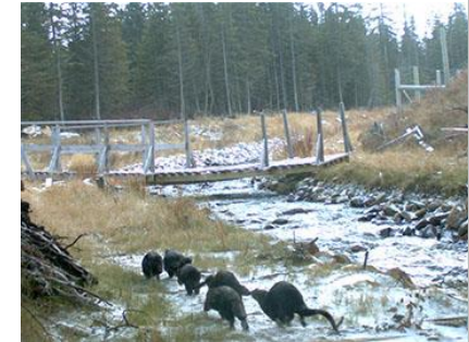
Passage faunique de la route 175 dans la réserve faunique des Laurentides © Transport Québec
